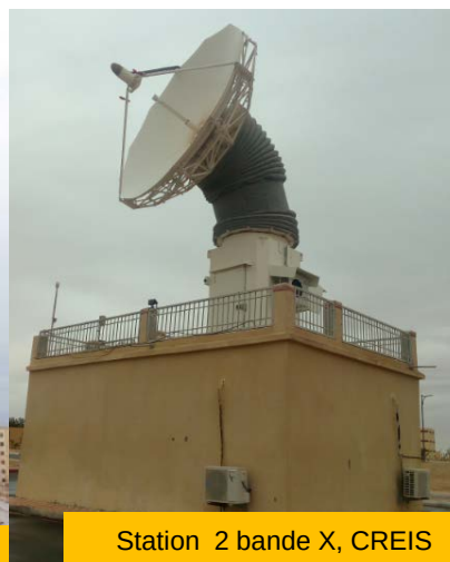
Station de réception et de control Oran
