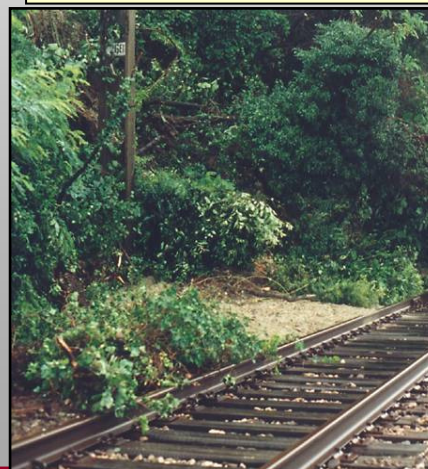
Разрушение полотна при развитии склоновых процессов в результате нарушения дренажа
