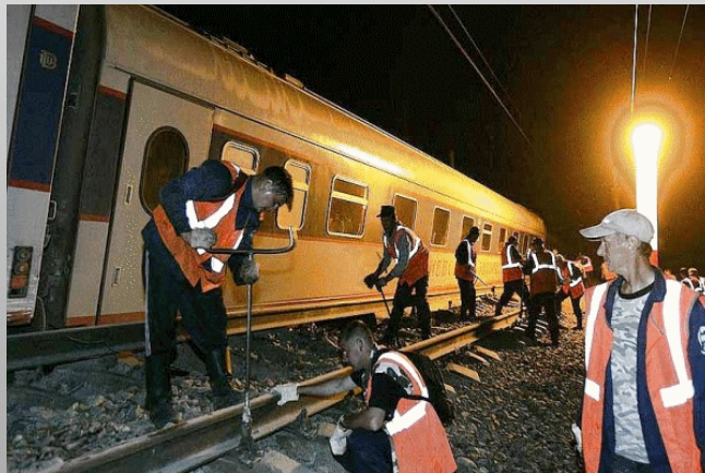
Проведение восстановительных работ на месте ЧС
