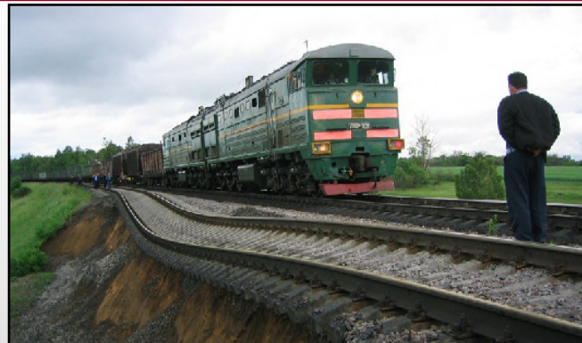
Разрушение полотна при развитии склоновых процессов в результате нарушения дренажа
